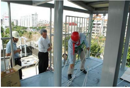
勞檢處 張處長 蒞場了解繩索系統
